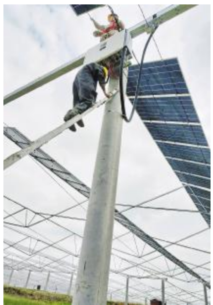
顶着高温,渔光物联运维人员检修设备
