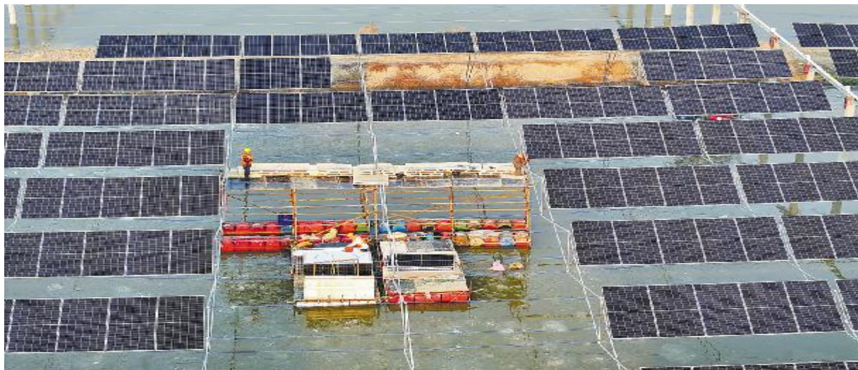
通威“渔光一体”项目建设现场
