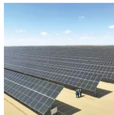
通威太阳能(组件)保供大唐磴口项目
