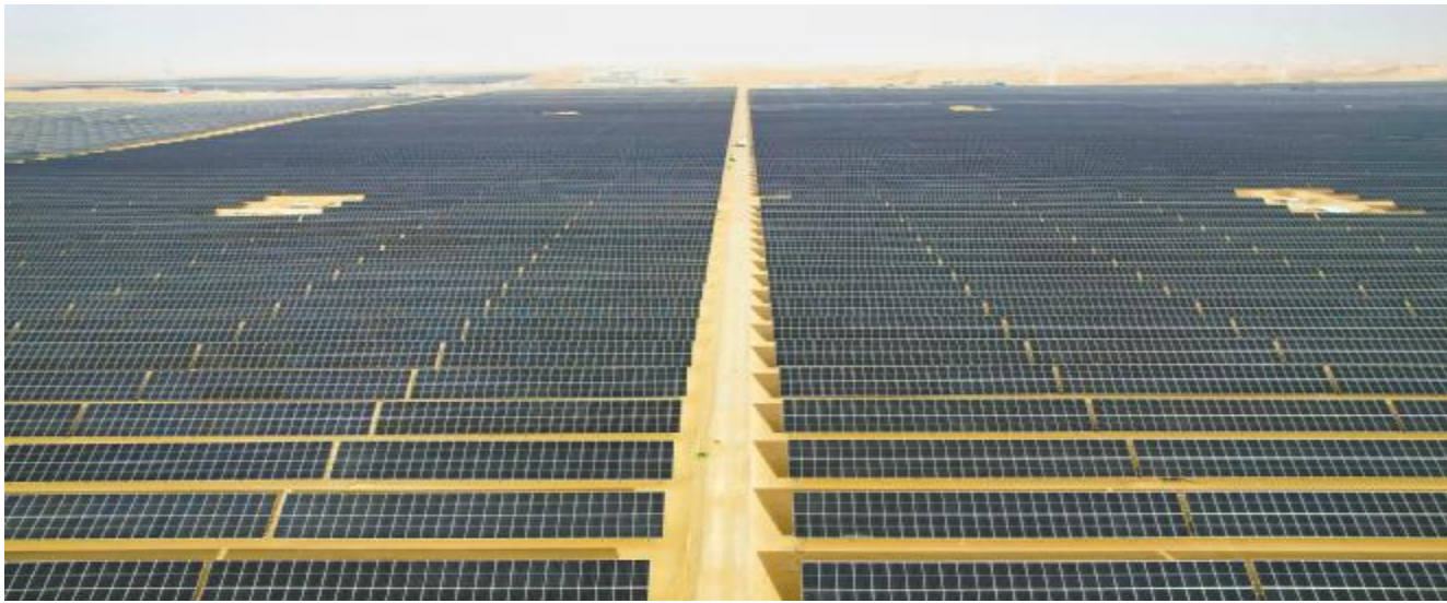
通威高效组件助力抗泰新能源 20 万千瓦光伏治沙项目
