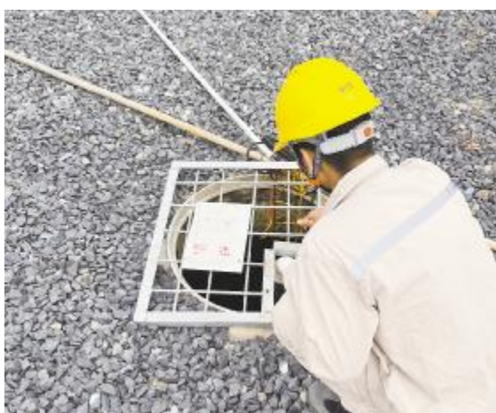
加固设施,防台风
