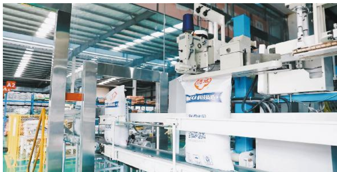
通威智能化生产车间
