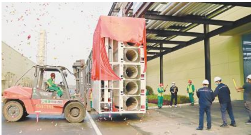
通合新能源电池项目二期设备进场
