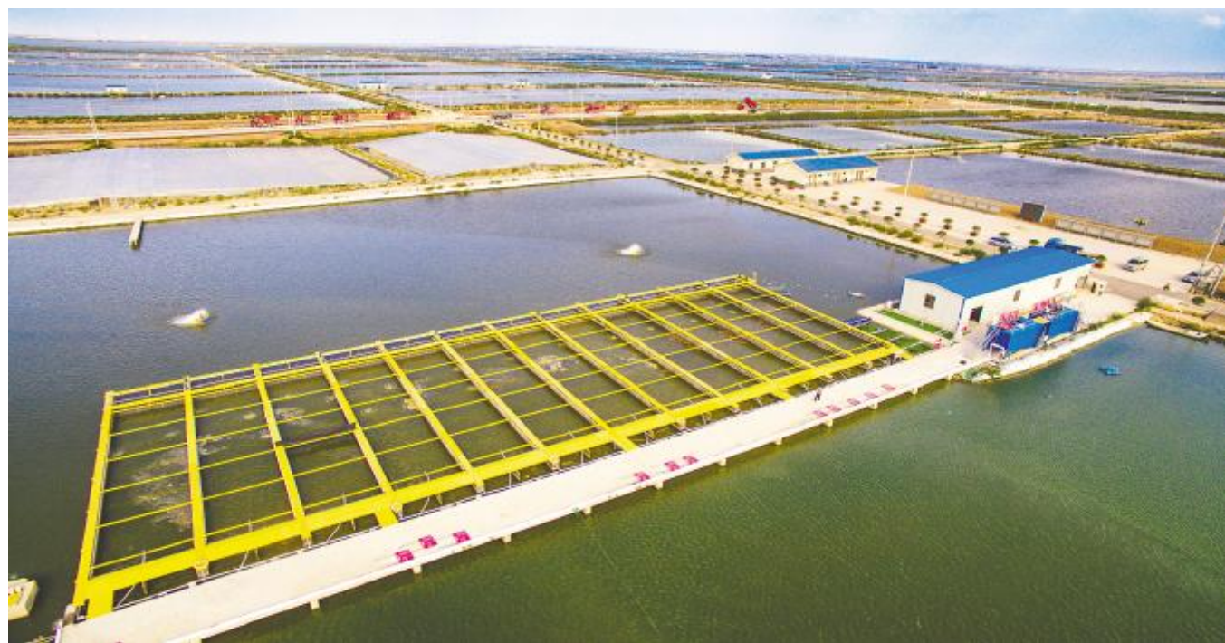
通威现代渔业产业园
