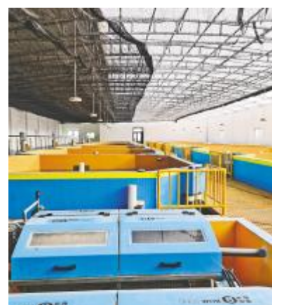
东营项目工厂化循环水养殖车间
