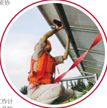
台山电站运维人员紧固螺栓
