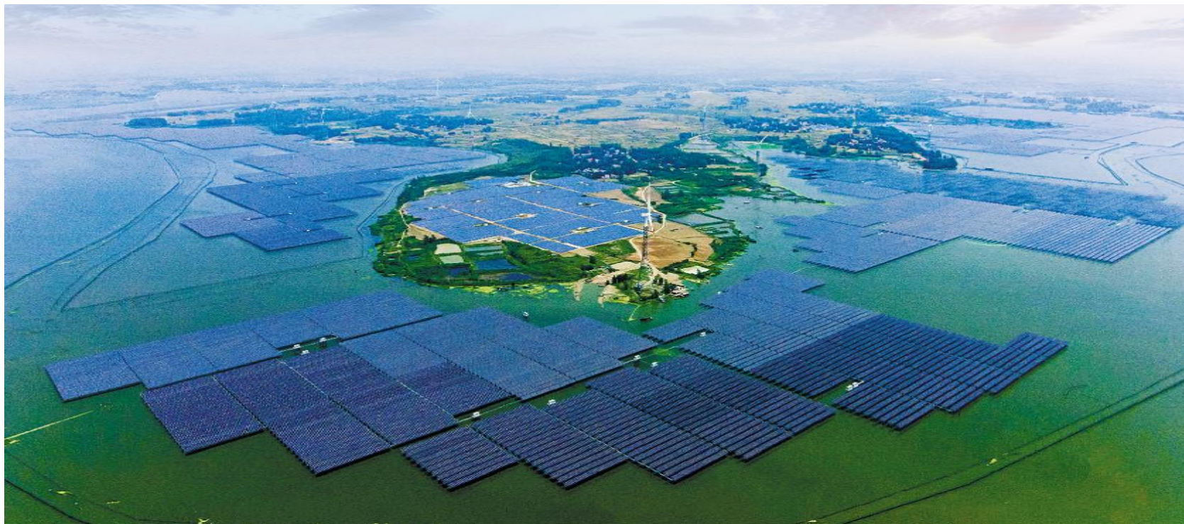
“渔光田园美”——通威泗洪“渔光一体”基地
